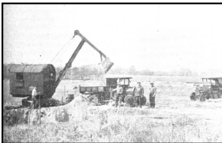
Les terrassements dans la future partie paysagère en 1935
